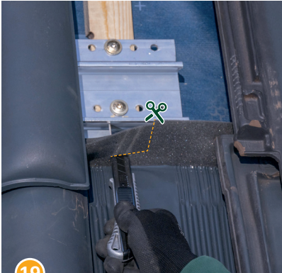
19 Schaumstoffkeil an der Position des Dachhakens mit einem L-Schnitt einschneiden.
